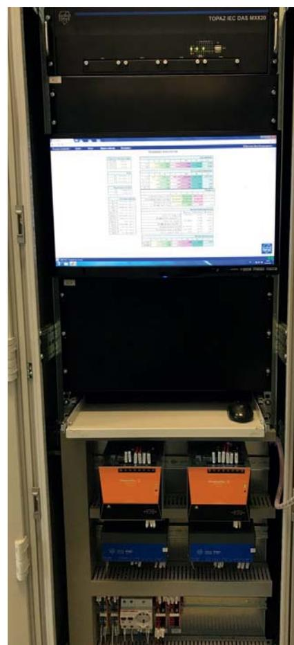
Рис. 6. Фото шкафа цифровой системы контроля качества электроэнергии TOPAZ iSAS® ККЭ на ПС 110 кВ «Бирюлево»
