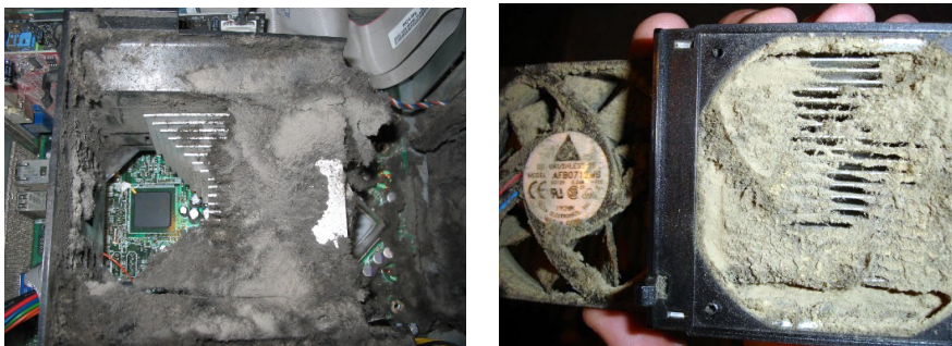
Рис. 2. Загрязнение элементов охлаждения из-за применения вентиляторов
