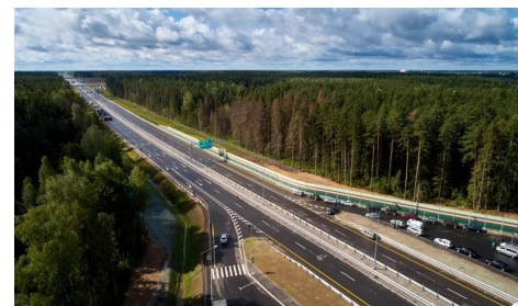
Трасса М-11 «Москва - Санкт-Петербург»
