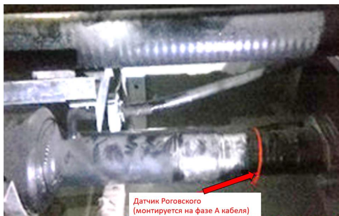
Рисунок 13 – Смонтированный датчик Роговского
