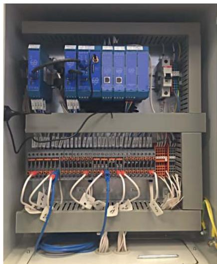
Рис. 6. Программно-технический комплекс TOPAZ FLISR
